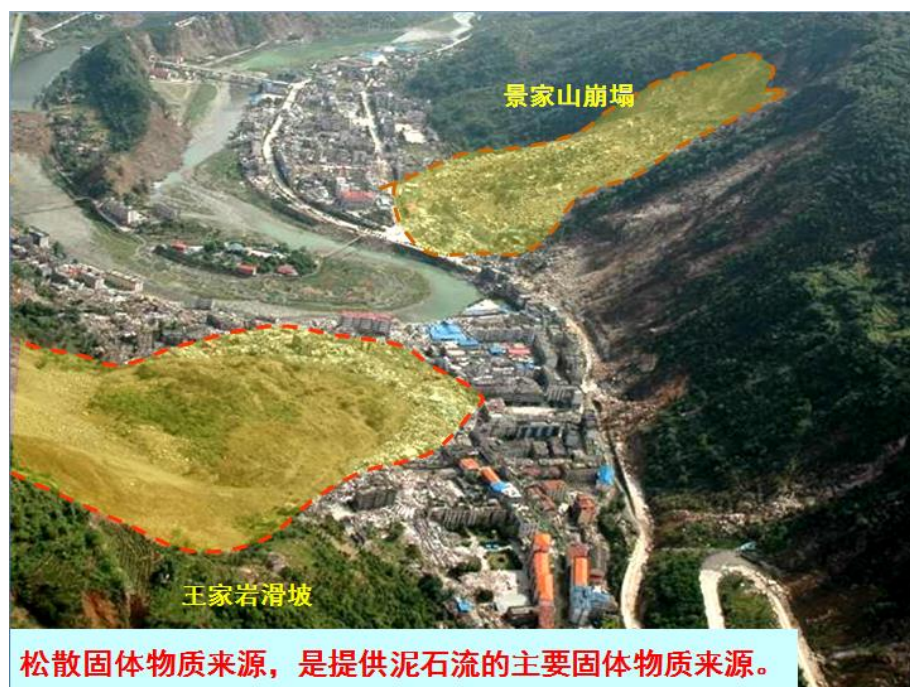
图4 “5.12地震”后的北川县城
