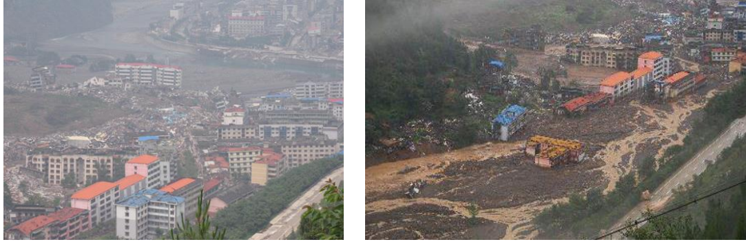
图5 泥石流发生前后的北川县城对比
