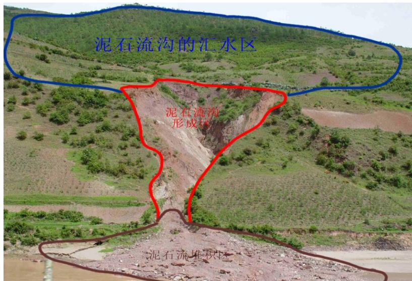
图 3 泥石流的三个区
