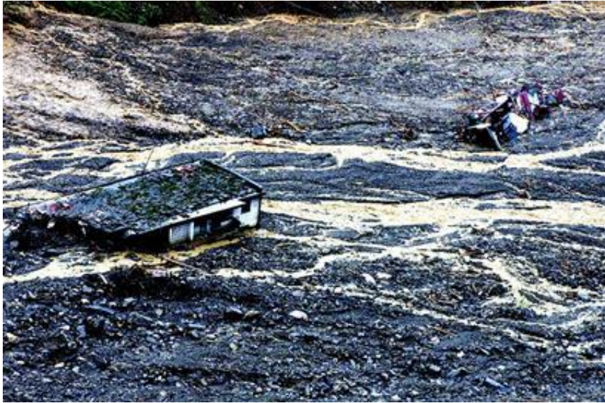
图 7 北川泥石流淹没房屋
