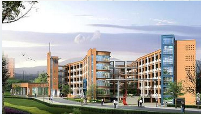
安装了空调的学生宿舍楼
