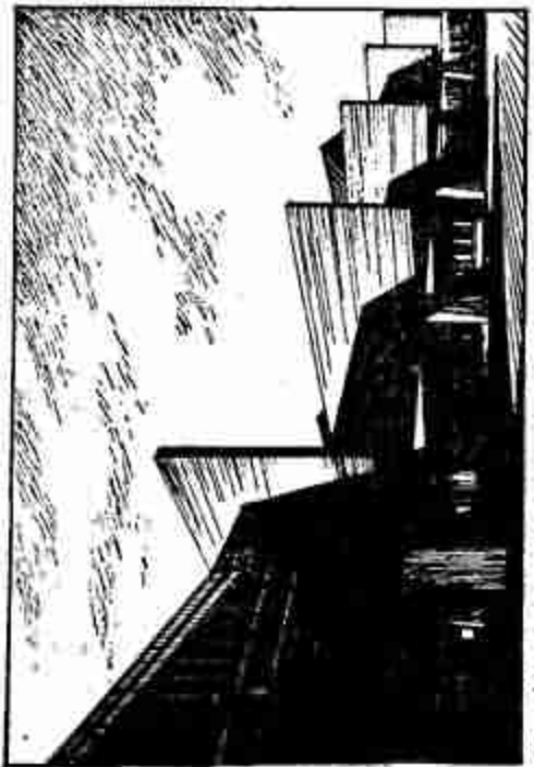
9 广场向左侧架起的支柱支撑着的玻璃幕墙。
